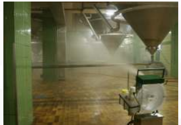
Desinfektion in einer Brauerei
